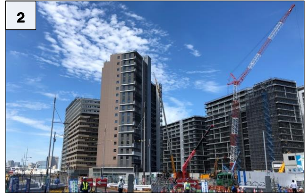
2 5-5 街区 地上躯体 くたい の整備状況
