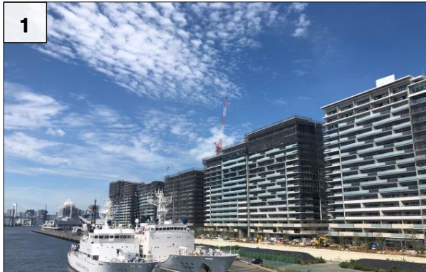
1 5-4 街区 地上躯体 くたい の整備状況
