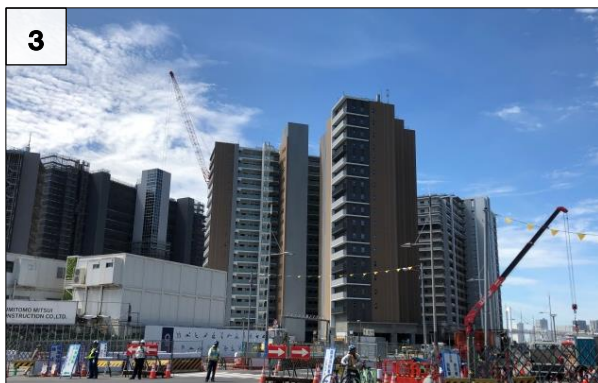
3 5-6 街区 地上躯体 くたい の整備状況
