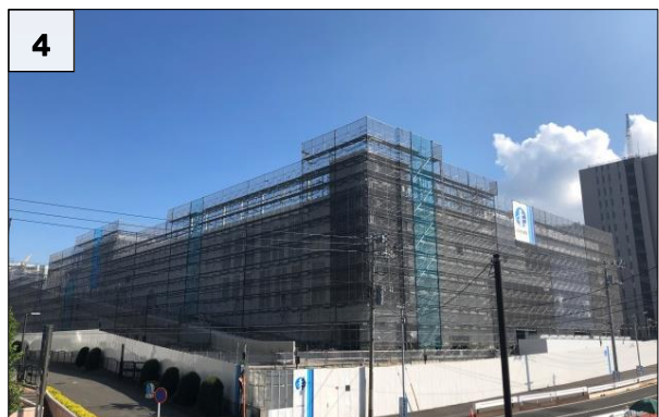
4 5-7 街区 地上躯体 くたい の整備状況
