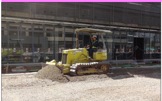
砕いた石をバックホウやブルドーザーで敷き均しています。
