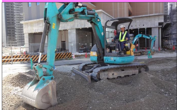
砕いた石をバックホウやブルドーザーで敷き均しています。
